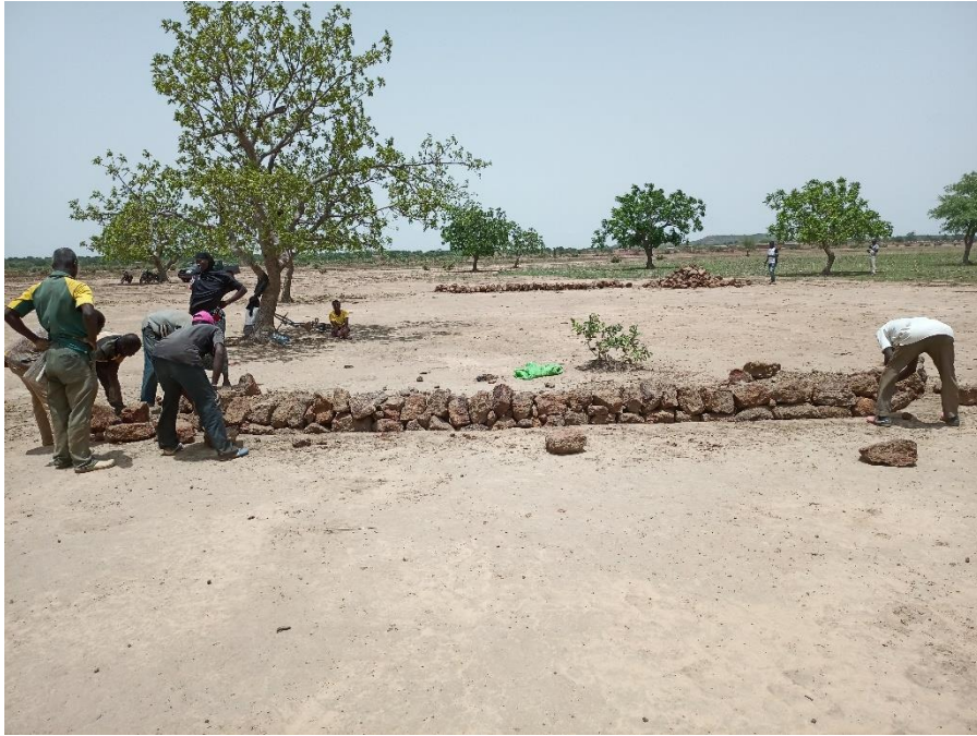
Figure 5: Mise en place du traitement T4, cordons trois pierres.
