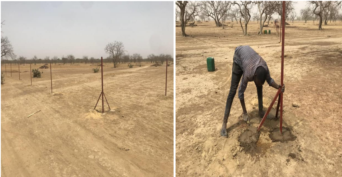
Figure 6: Mise en place de la clôture en fer barbelé.
